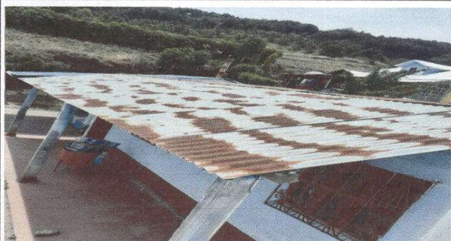
Foto1: Sustitución de lamina, por lamina troqueleqda aluzinc calibre 26
